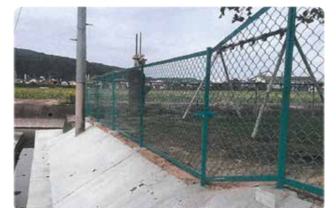
▲ 常広区:ちびっこ広場のフェンス整備
